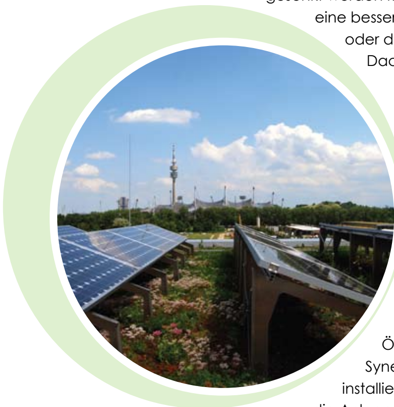
Kombination von Extensivbegrünung und Photovoltaikanlage auf dem Gebäude des Münchner Technologie-Zentrums
