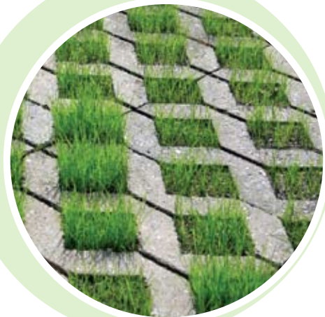
Rasengittersteine verringern die Bodenversiegelung
